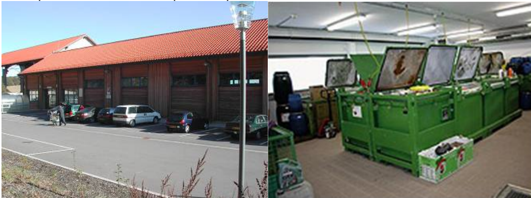
Graph. : 3 Centre de recyclage avec point de collecte fixe de la SuperDrecksKëscht
