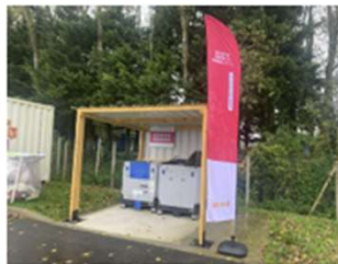
Flamme pour signaler la zone de dépose
